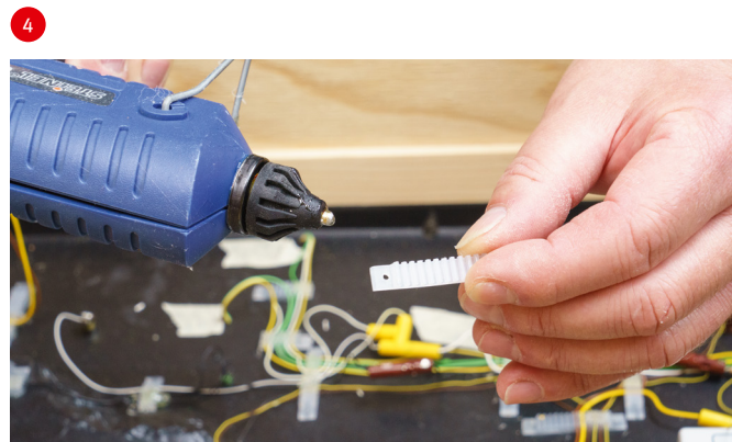
Einfach ankleben: Tackern geht auf der Kunststoffanlage nicht, deshalb werden die Kabelhalter einfach und flink mit der Klebepistole befestigt.
