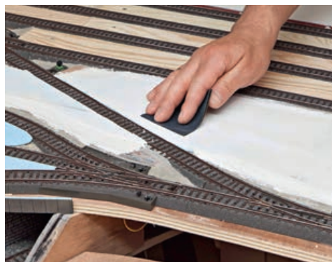
Die verspachtelten Platten werden durch vorsichtiges Schleifen für den Anstrich vorbereitet.
