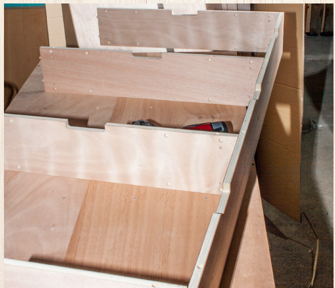
Die Einzelteile der Modulelemente haben wir vor Arbeitsbeginn (im Hintergrund noch leicht erkennbar) vorsortiert – so sind sie schnell zur Hand.
