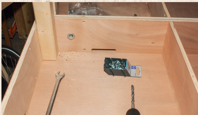
Neben dem angebrachten Standbein ist bereits die erste Schraubverbindung zwischen zwei Modulen zu erkennen.
